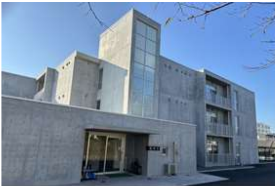
令和 6 年 6 月に竣工した優峰寮
