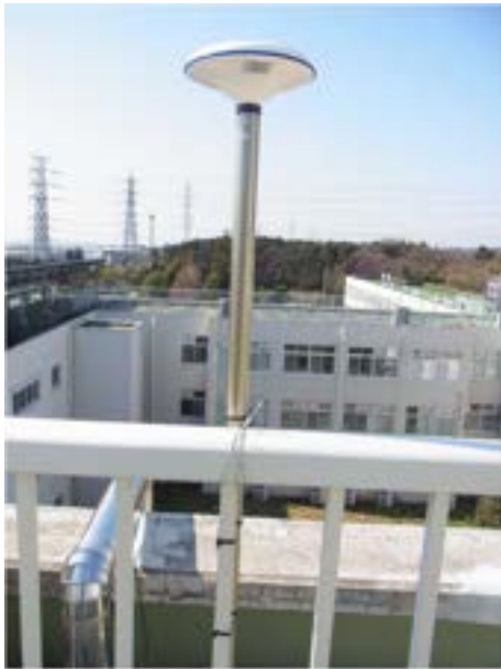
図1 電子制御棟屋上に設置した基準局アンテナ
