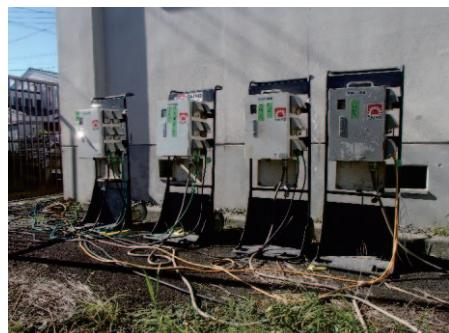
図 7 仮設分電盤の設置
